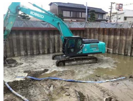
重機も同様に走行できます。
